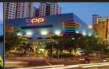
Bukit Panjang Plaza
