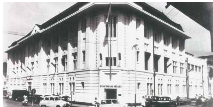
Bank Dagang Negara, Jl. Pintu Besar Utara, 1966
