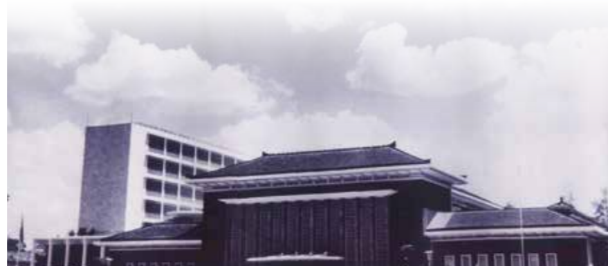
Bank Pembangunan Indonesia, Jl. RP Soeroso, Menteng, 1970
