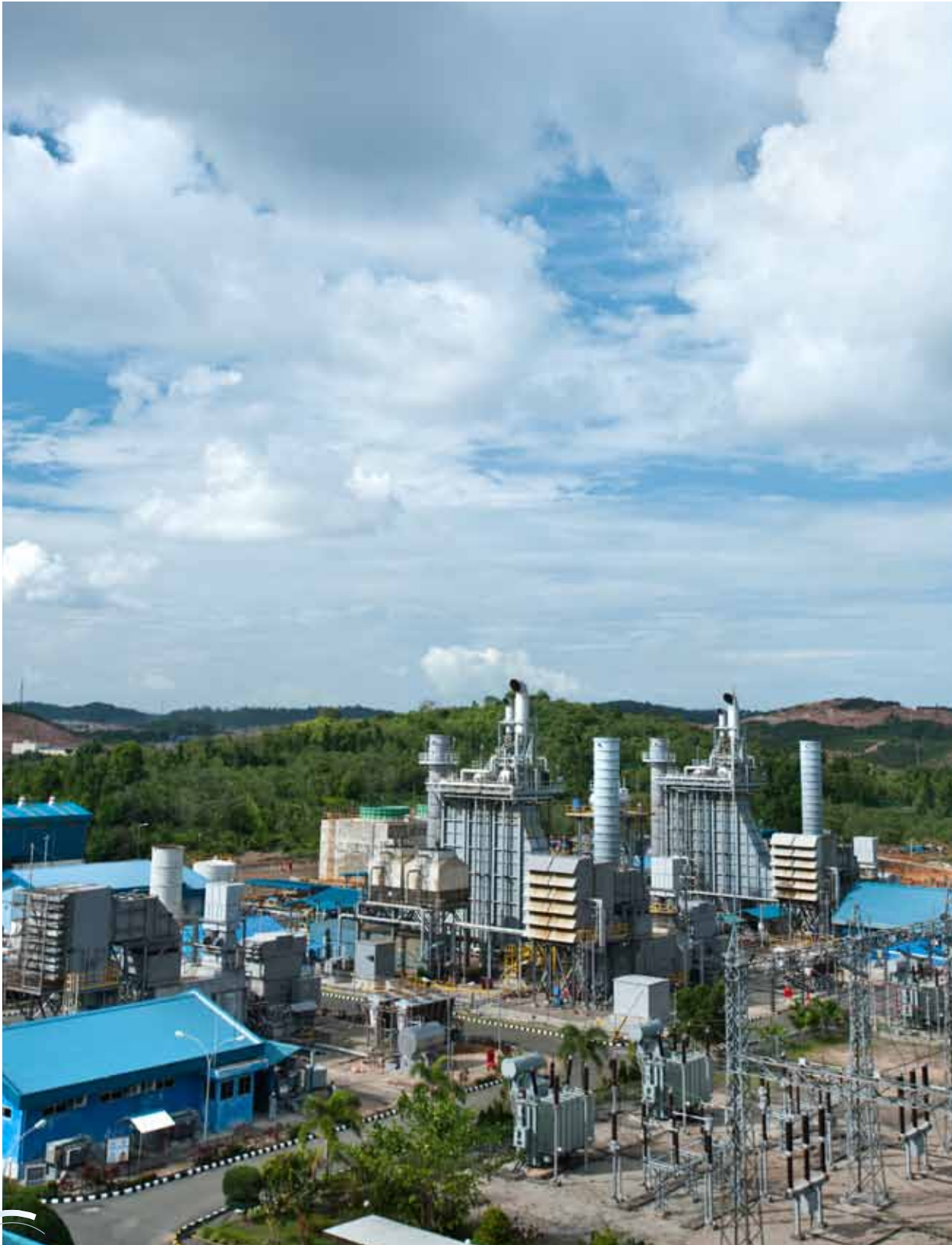
PT Dalle Energi Batam merupakan pelanggan terbesar PGN di Batam, mempergunakan gas bumi bagi Power Non PLN.
