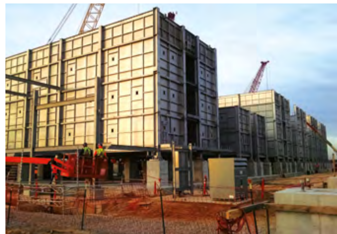
Chaudière en modules installée sur fondations par Fluor Technip Integrated.
