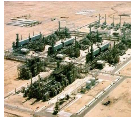
Qatargas II LNG Plant
