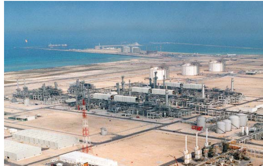
Ras Laffan LNG site
