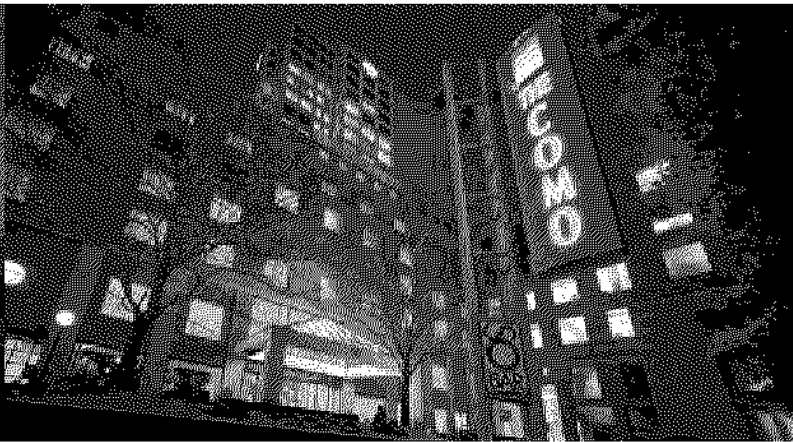
THE COMO 830 Chapel Street, South Yarra, VIC
