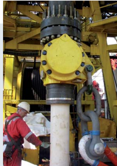
Connexion de risers
