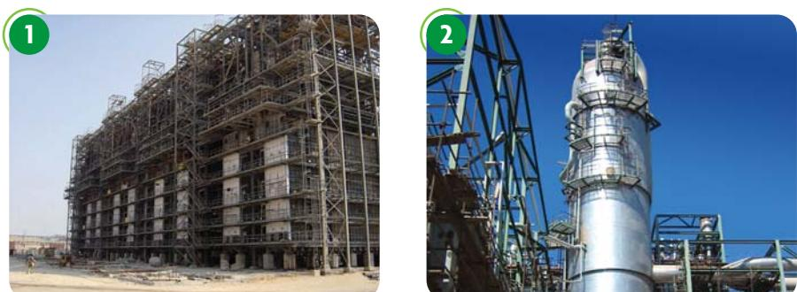
**D**es fours, dans lesquels s'effectue le craquage thermique, selon une technologie propriétaire de Technip. Pour obtenir une température de réaction de 850 °C, la température des parois doit atteindre au moins 1 300 °C.
