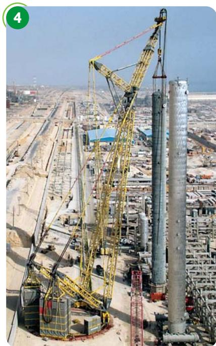
**4** Une section de séparation froide (cryogénique), technologie propriétaire de Technip, qui sépare l'éthylène des autres produits. Cette section comporte des colonnes de purification (80 m de hauteur) produisant de l'éthylène dont le taux de pureté s'élève à 99,99% !
